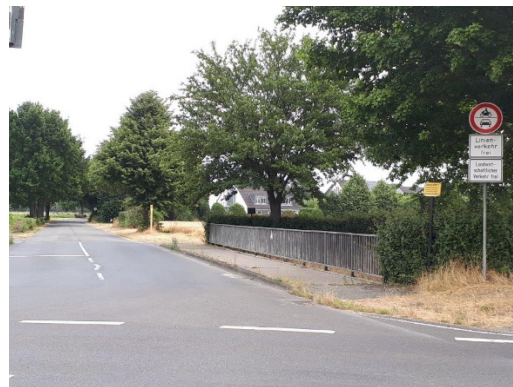
Hauptstraße an der Randkanalbrücke
